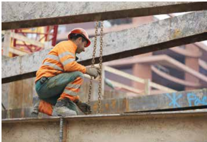
Die Spriessung dient der Aufnahme grosser Kräfte.
