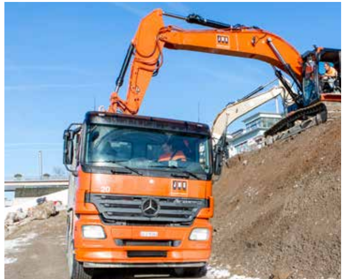
Aushubmaterial auf Lastwagen verladen
