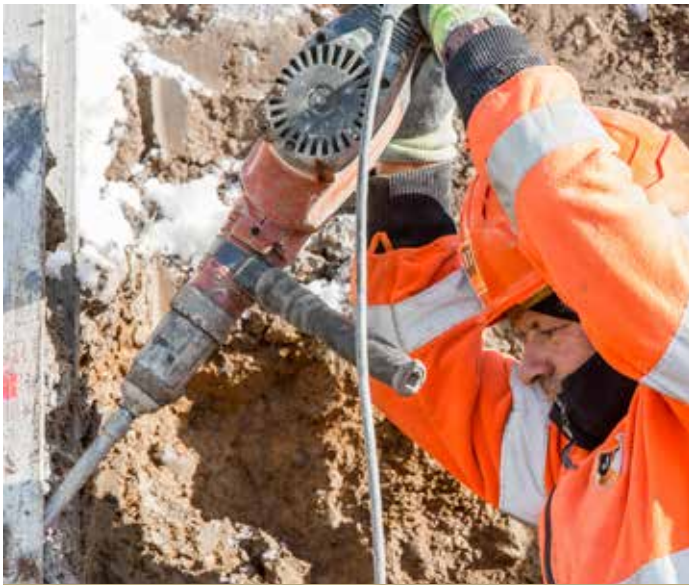
Vorbereitung für die Rühlwand Ausfachungen
