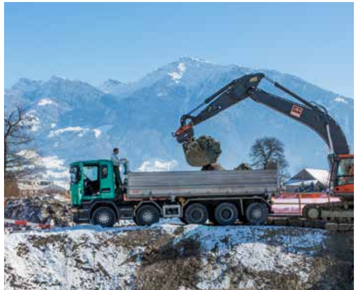
Aushubmaterial auf Lastwagen verladen
