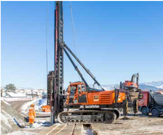
Betonrammpfähle einbauen
