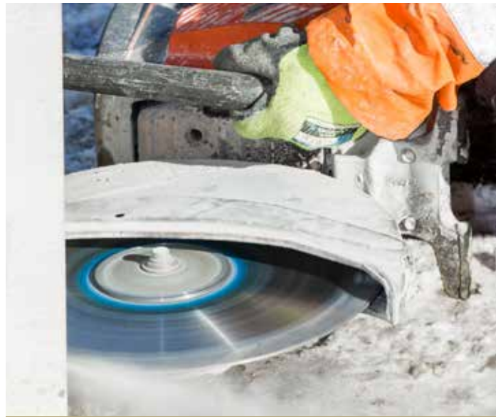
Abtrennen von Betonpfählen
