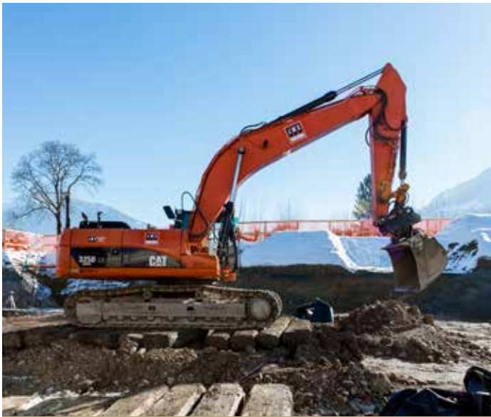
Baugrubenaushub
