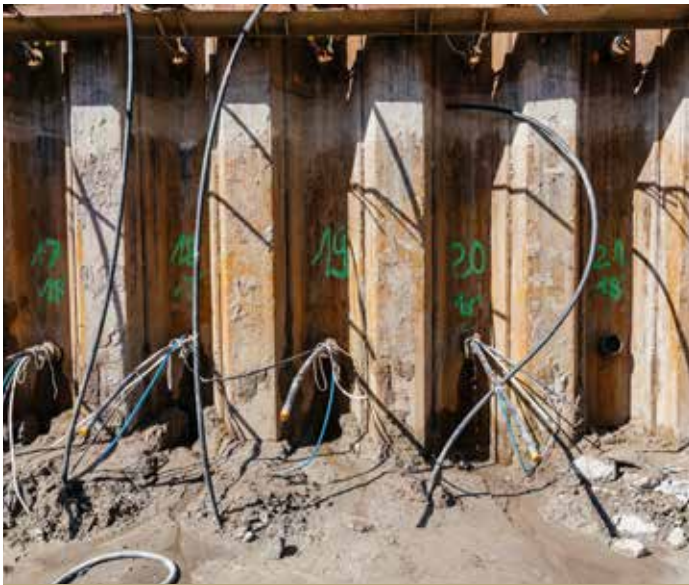
Einbau der Anker
